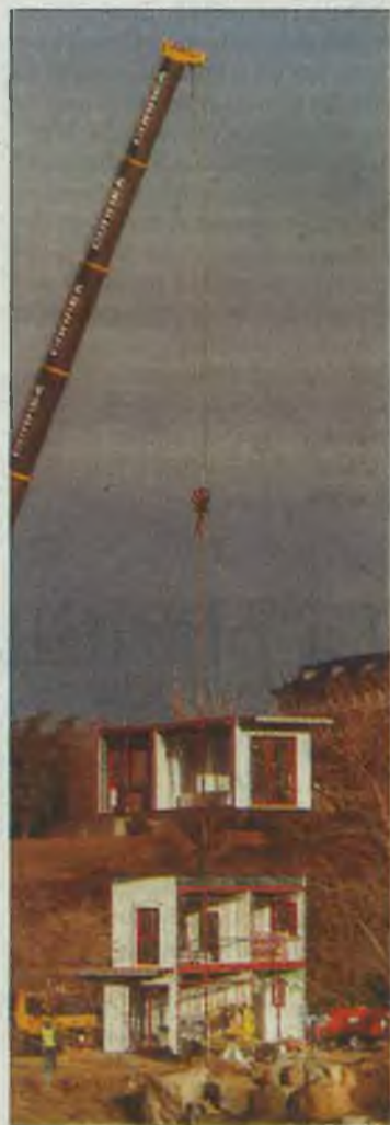
Instalación de uno de los módulos. / D.C.
