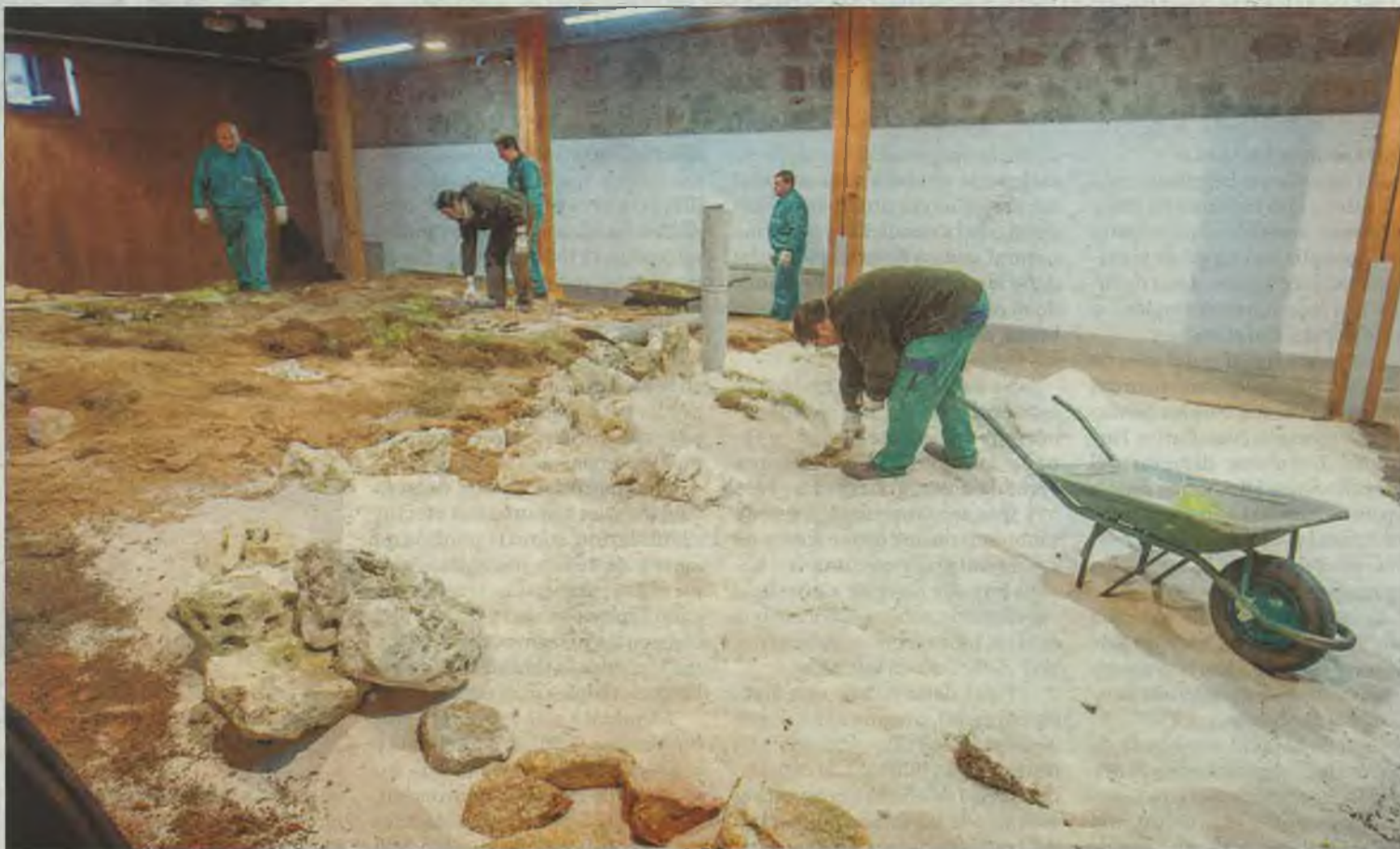
Varios operarios municipales trabajaban estos días en el desmontaje del belén instalado en el Episcopio. / ANTONIO BARTOLOMÉ
