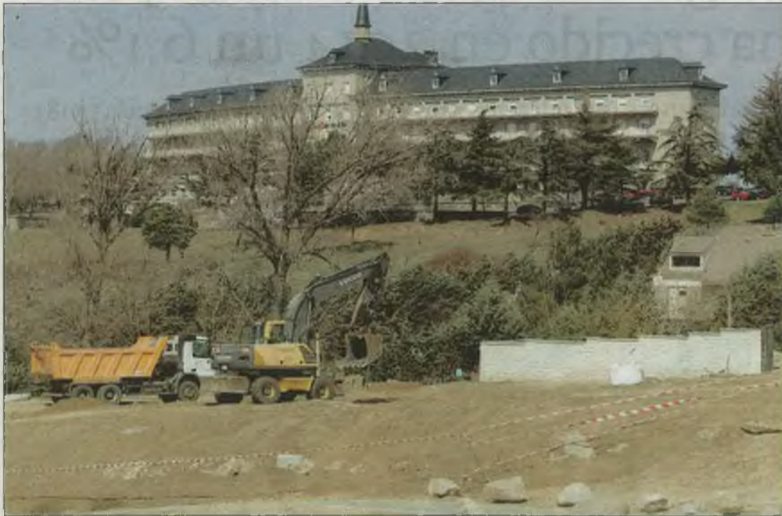
El movimiento de tierras en la parcela del albergue ya ha comenzado. / DAVID CASTRO
