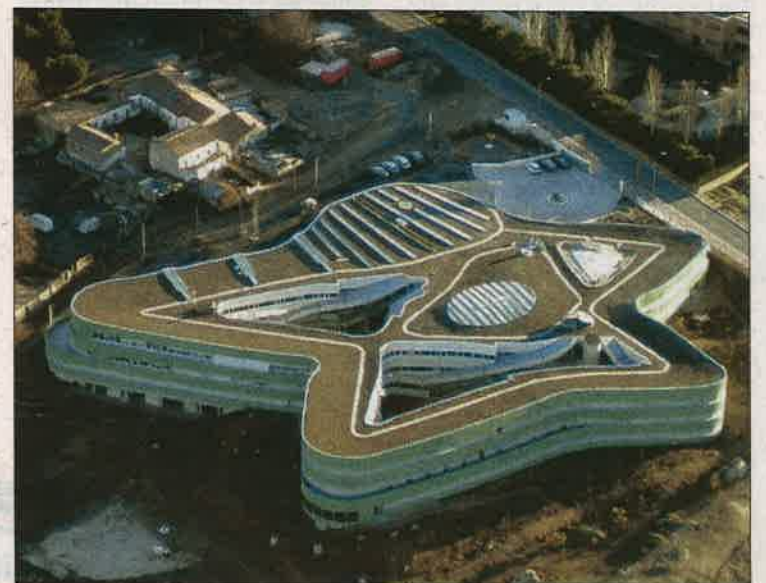
Edificio del Cites.
