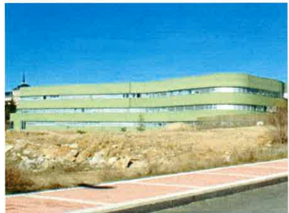
Edificio de la Universidad de la Mística
