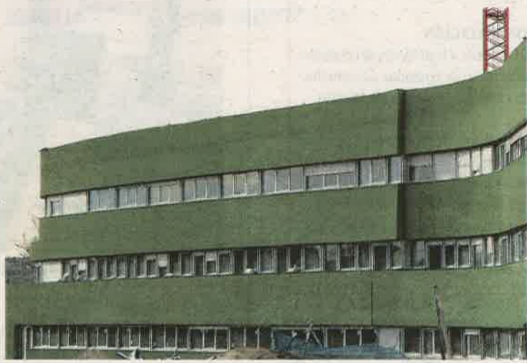
Las obras del edificio están casi finalizadas.
