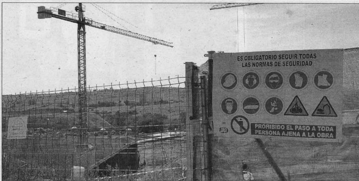
Lugar donde se construye la nueva sede del Cites. /ANTONIO BARTOLOMÉ
